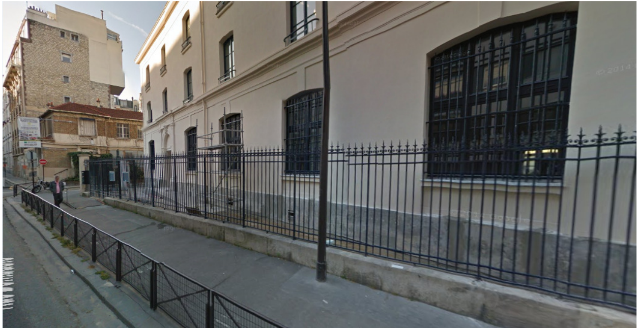
Rue Dombasle, Paris
